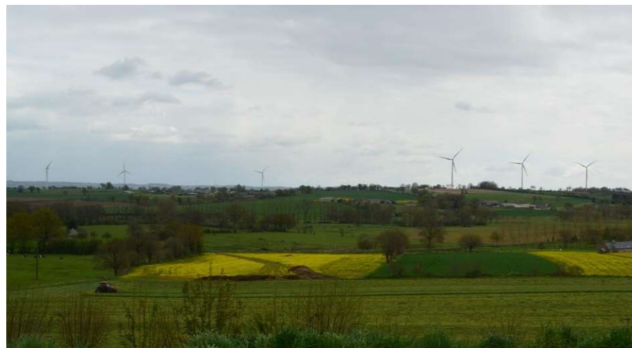
Les éoliennes du parc éolien de la Haie-Oisseau (Source : SARL Laurent Coüasnon)
